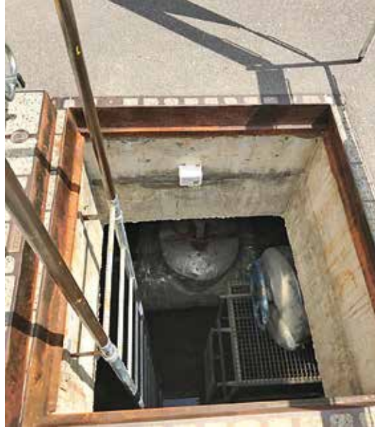
Die Datenübertragung vom LPN CM-4 Sensor von comtac funktioniert auch unter einer massiven, metallverstärkten Abdeckplatte.
